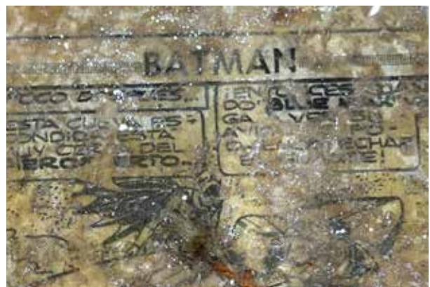
Rastro de papel periódico utilizado en intervención anterior
