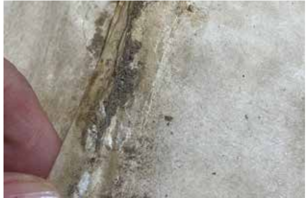
Depósitos de suciedad acumulada en los cuadernillos
