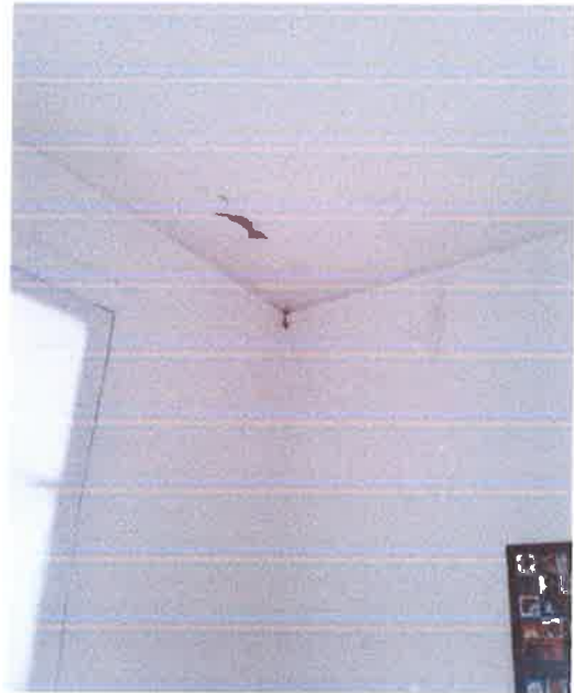
Imágenes 01 y 02. Impacto de lluvias (goteras) en pisos y techos de salas de conservación y depósito temporal. 2021
