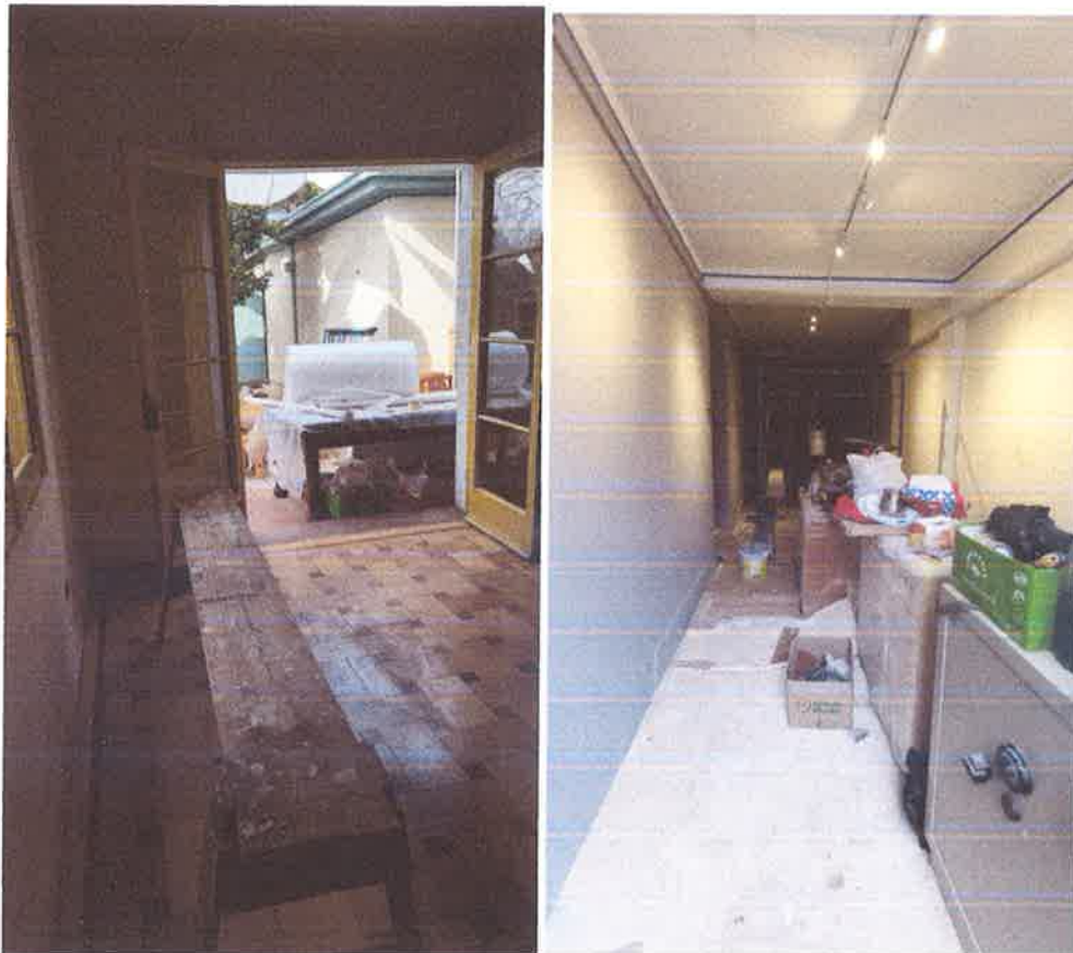
Imágenes 05 y 06. Obras de reparación de muros y pintura. 2022
