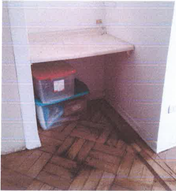
Imágenes 01 y 02. Impacto de lluvias (goteras) en pisos y techos de salas de conservación y depósito temporal. 2021
