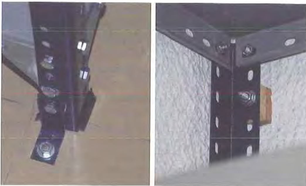
Fig. 29 y 30 Detalle de los puntos de anclaje.
