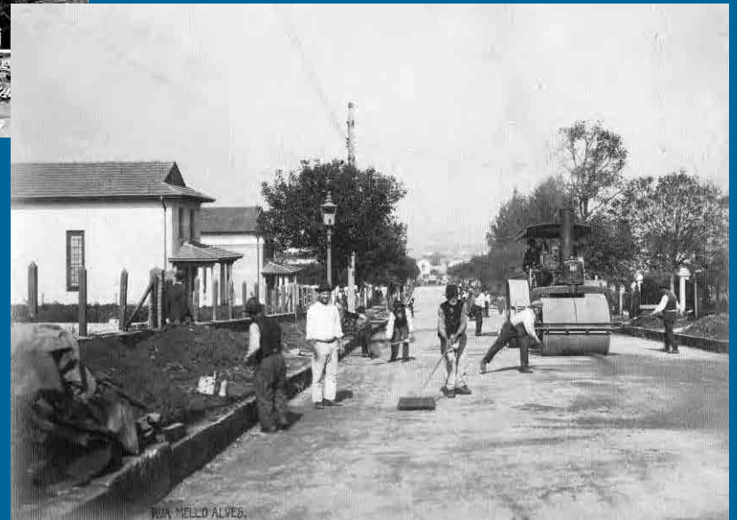
Pavimentação da rua Melo Alves, 1920c.
