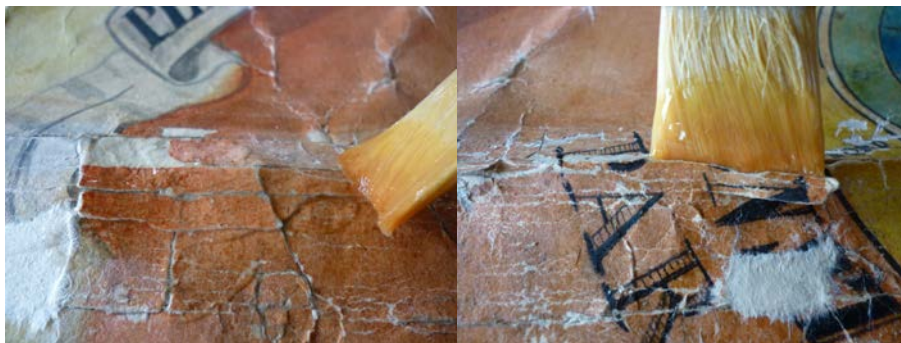
Foto 9. Consolidación y fijado.
