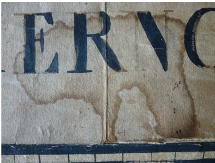
Foto 7. Manchas producidas por humedad.
