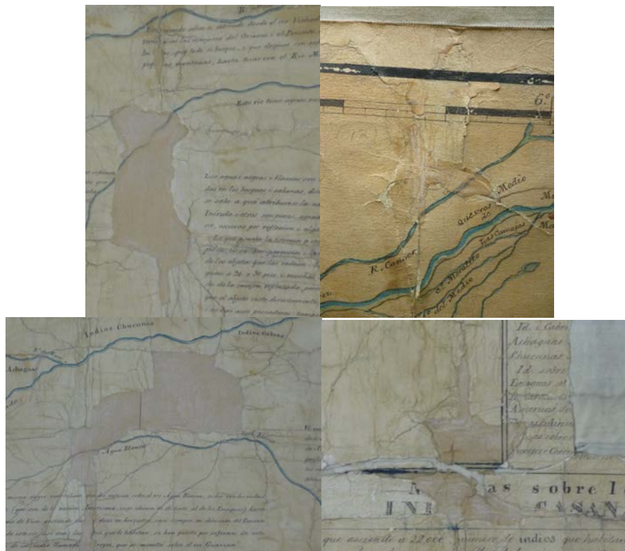
FOTO 7. INJERTOS SOBRE FALTANTES ESTRUCTURALES DE INTERVENCIÓN ANTERIOR CON REINTEGRACIÓN CROMÁTICA Y DE INFORMACIÓN.
